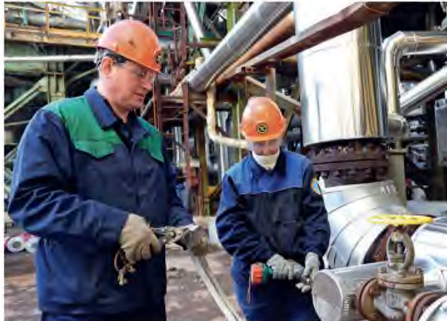
Задача изолировщиков – исключить теплопотери на трубопроводах и оборудовании. Ничего не должно остывать или обжигать
